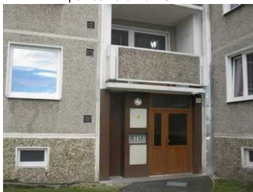
zadní vstup do bytového domu
