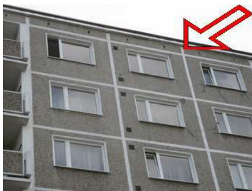
pohled na okna v 8.NP
